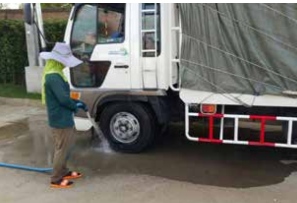
▲ ทำความสะอาดรถก่อนออกจากโครงการเพื่อควบคุมไม่ให้ฝุ่นละอองฟุ้งไปนอกพื้นที่ก่อสร้าง
