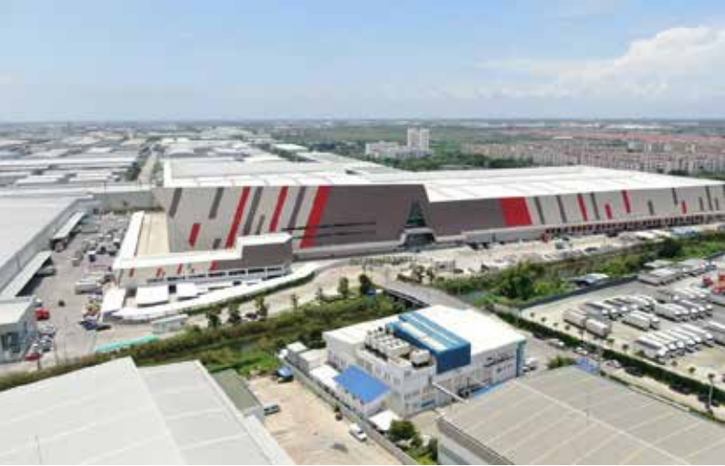
▲ ศูนย์กระจายสินค้า Omnichannel ตั้งอยู่ในโครงการเฟรเซอร์ส พร็อพเพอร์ตี้ โลจิสติกส์ เซ็นเตอร์ บางพลี
