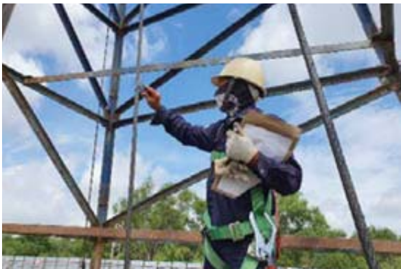
ภาพการแต่งกายของผู้รับเหมาสำหรับงานบนที่สูง
